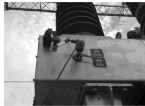
35KV SF6 开关传感器安装
